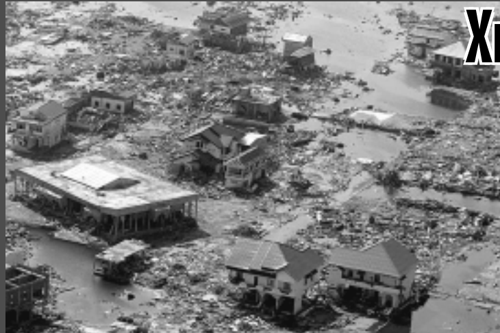
Въздушна снимка, направена от самолетна група на американския самолетоносач Абрахам Линколн, разкрива опустошението, причинено от вълните цунами, ударили провинцията Банда Ачех в Индонезия.
